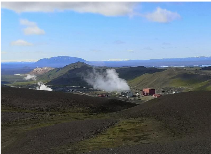
La centrale geotermica
