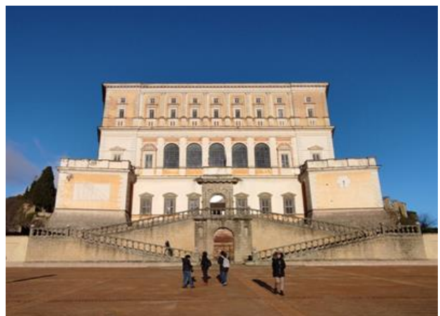
Palazzo Farnese - Facciata
