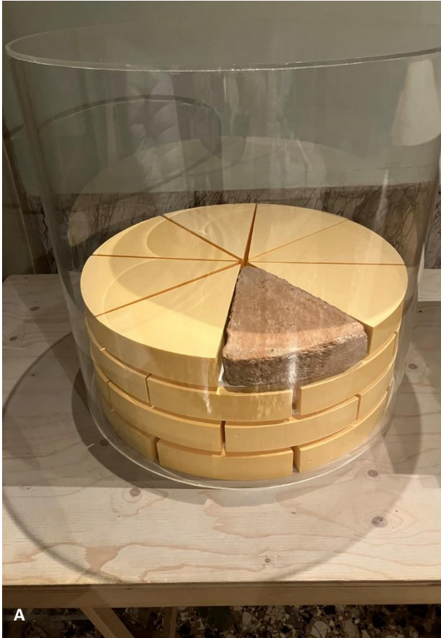
Figura 3 A) Campione di un modello tecnico-costruttivo delle “colonne libere all’antica”: i mattoni a “lunette”, elementi laterizi a forma triangolare, disposti a formare dei dischi per le colonne.
