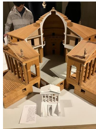
Figura 2: Plastico della Villa Almerico Capra detta La Rotonda e spaccato del suo interno, a pianta centrale, sullo sfondo della prima foto si notano le bacheche contenenti i Quattro Libri dell'Architettura. (Foto: P. Pedrocco).
