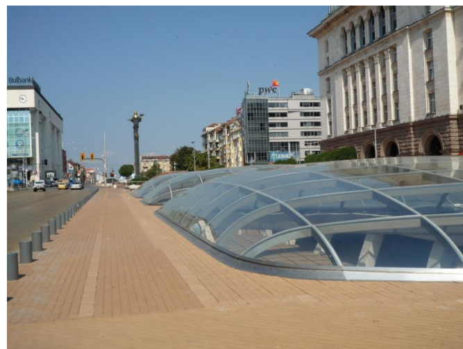
Cupole a protezione degli scavi archeologici
