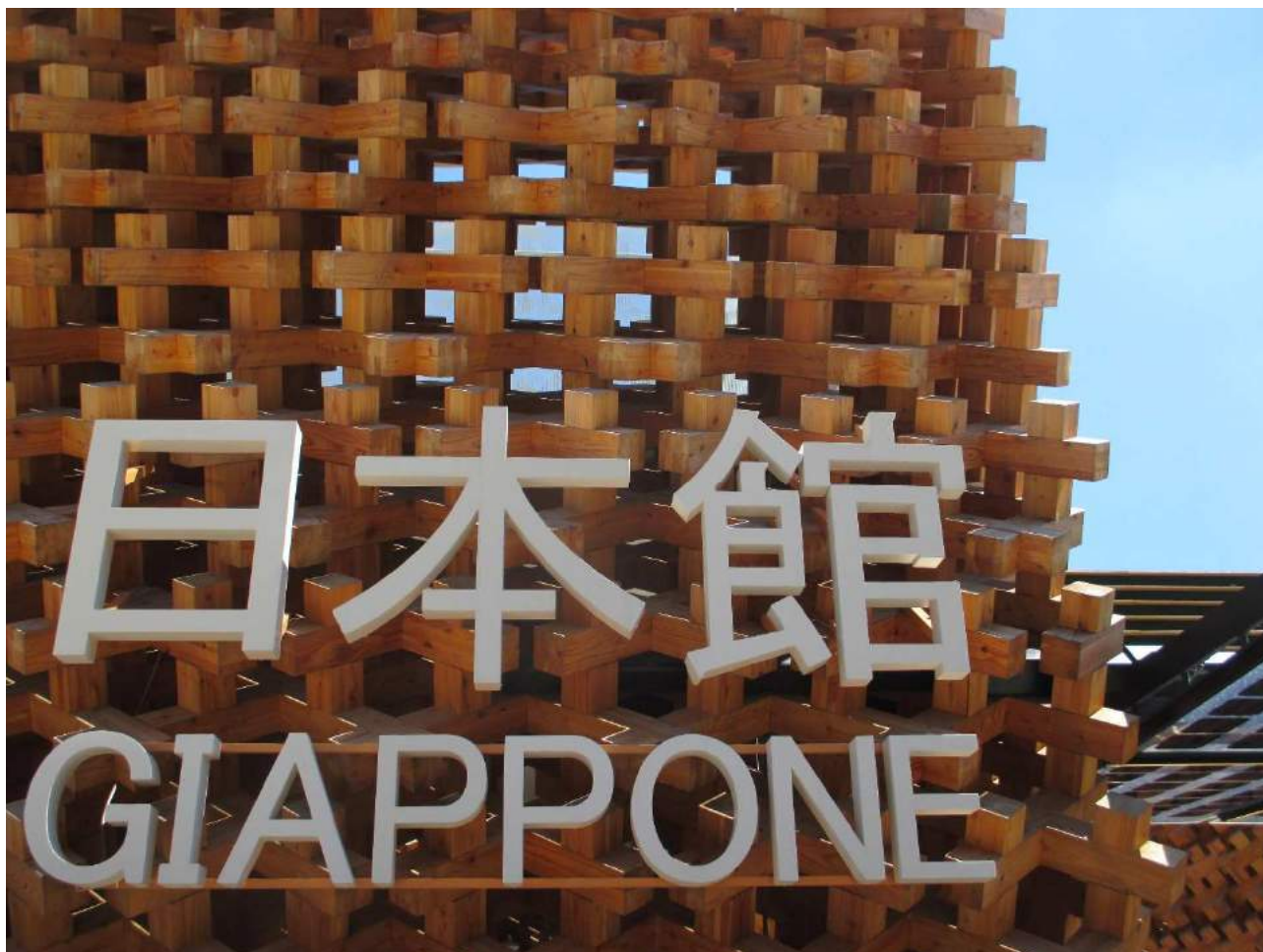
291 Padiglione Giappone, dettaglio pareti perimetrali.
