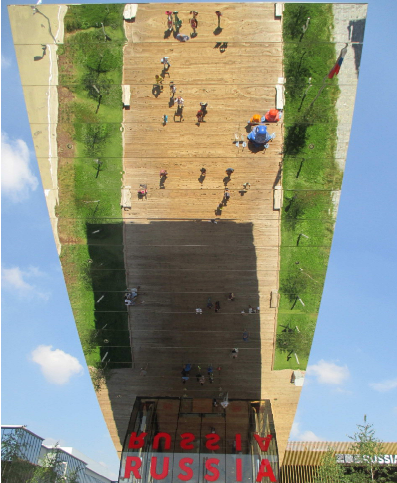
281 padiglione Russia, sbalzo di copertura sul fronte principale.
